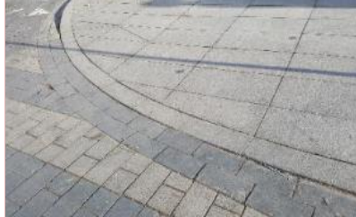
Patogi danga, šaligatvis ir gatvė viename lygyje, tačiau neįrengtas įspėjamasis paviršius.
