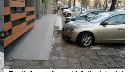
Pėstieji negali pereiti šaligatviu dėl neįrengtų stovėjimo bortelių. Laiptai ir pandusas taip pat įrengti netinkamai.
