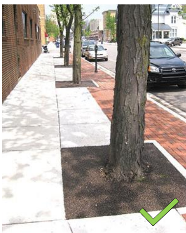
Medžių šaknynas apsaugotas nebiria, orui ir vandeniui laidžia medžiaga
