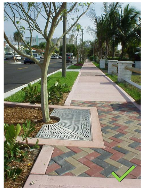
Medžio šaknynas apsaugotas metalinėmis grotelėmis
