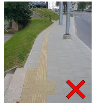
Neregijų vedimo trasa veda tiesiai į kliūtis, vedimo sistemos paviršiai sunkiai matomi dėl mažo kontrasto su šaligatvio danga
