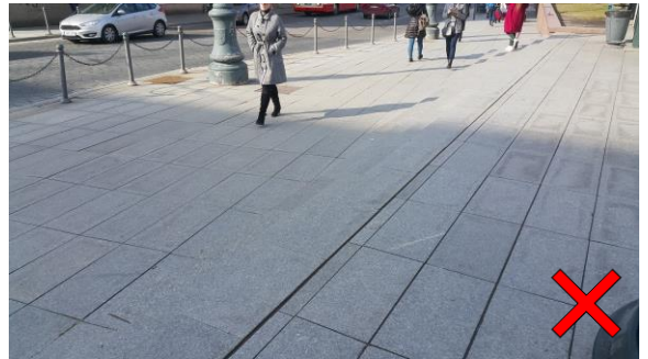
Neįrengti įspėjamieji paviršiai ir kontrastingos spalvos juostos, todėl laiptai visai nepastebimi
