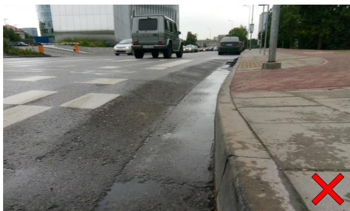
Netinkamai suvestas pėsčiųjų takas ir iškilioji perėja – griovys prieš iškilniąją pėsčiųjų perėją
