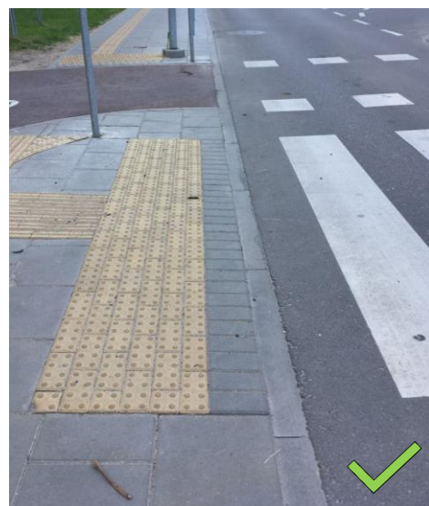
Tinkamai įrengta neregijų vedimo sistema, nėra aukščių skirtumo tarp dangų, tačiau apšvietimo ir kelio ženklų stulpai įrengti ne vienoje linijoje
